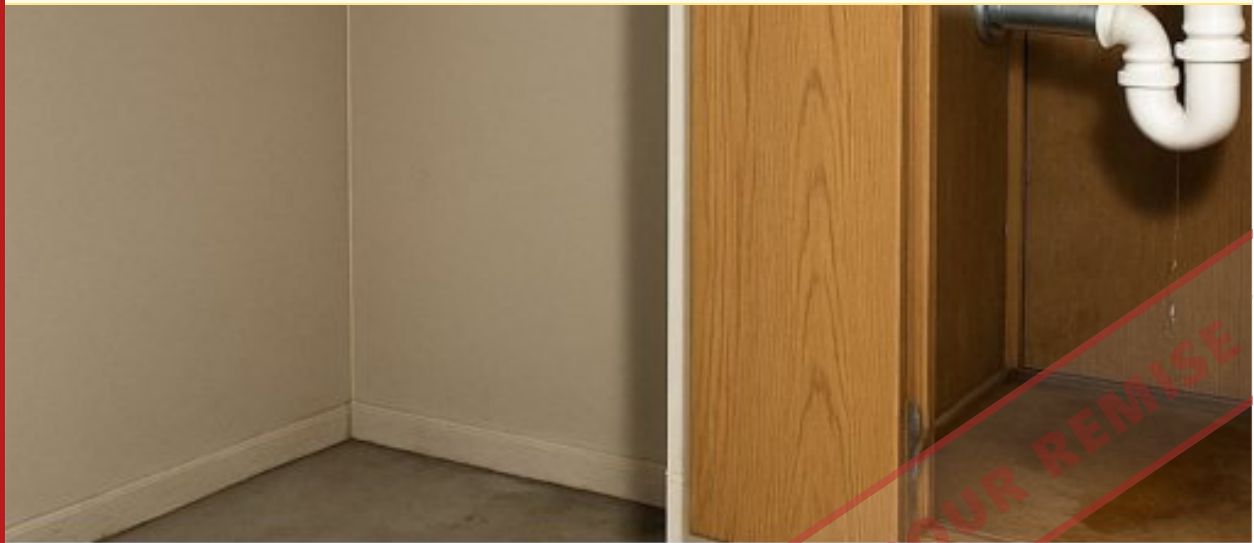
Figure PLO-01-a — Sous-sol, pres du drain de plancher
