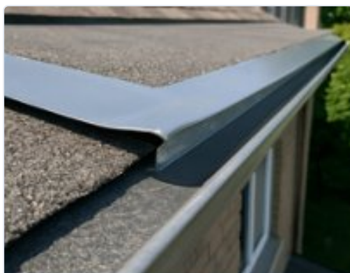
Figure TOI-01-a — Autour de la cheminee sur le toit
